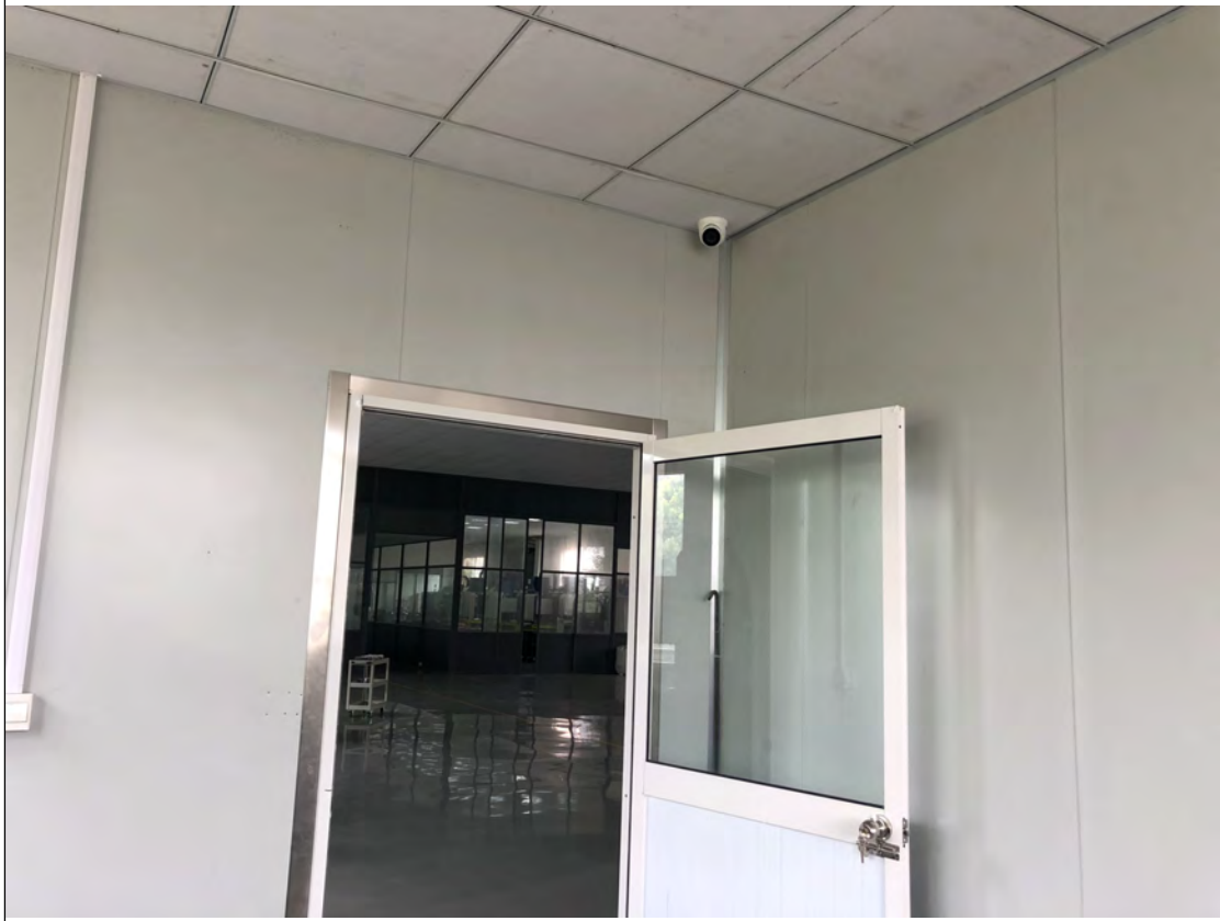
图片说明：危废仓库内部探头设置情况。
